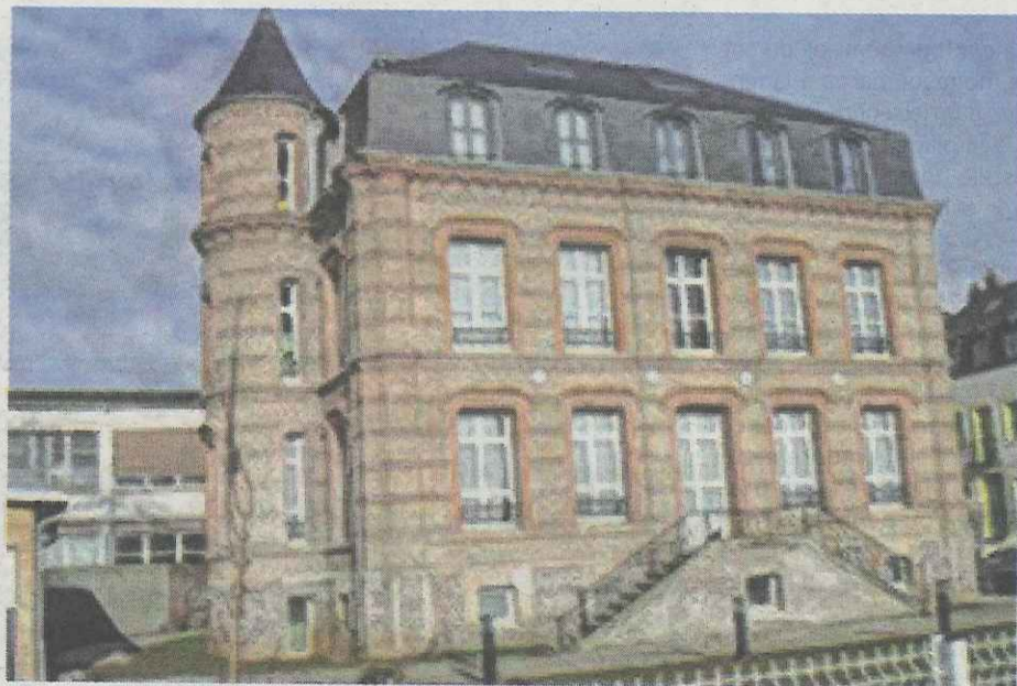
Le manoir de l'APEI accueille le service du Sessad, avenue de l'Entrepôt.
